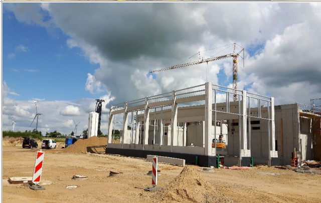
Stahlbau - Unterkonstruktion der Fassade am Bauteil E Milchannahme montiert
