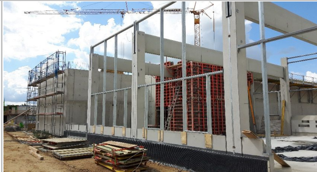
Stahlbau - Unterkonstruktion der Fassade am Bauteil A 3 Produktion montiert
